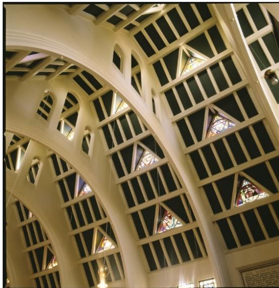
Le détail des arcs-diaphragmes en béton
