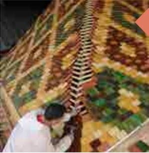
*Après les travaux, les toitures de la cathédrale de Tournai ont retrouvé toute leur splendeur, sous les mains expertes des ouvriers mettant en place des tuiles vernissées colorées.*
