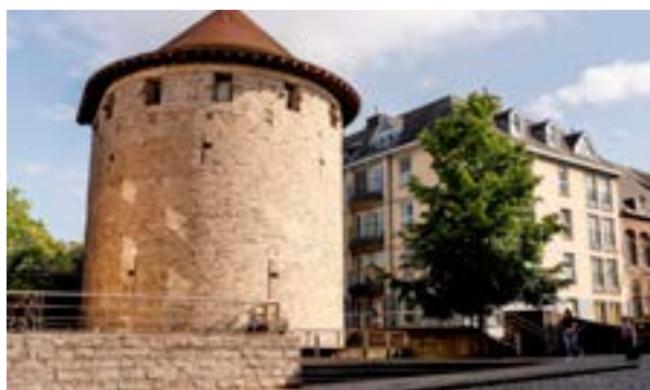
Le fort rouge, Tournai accès exceptionnel AWaP
